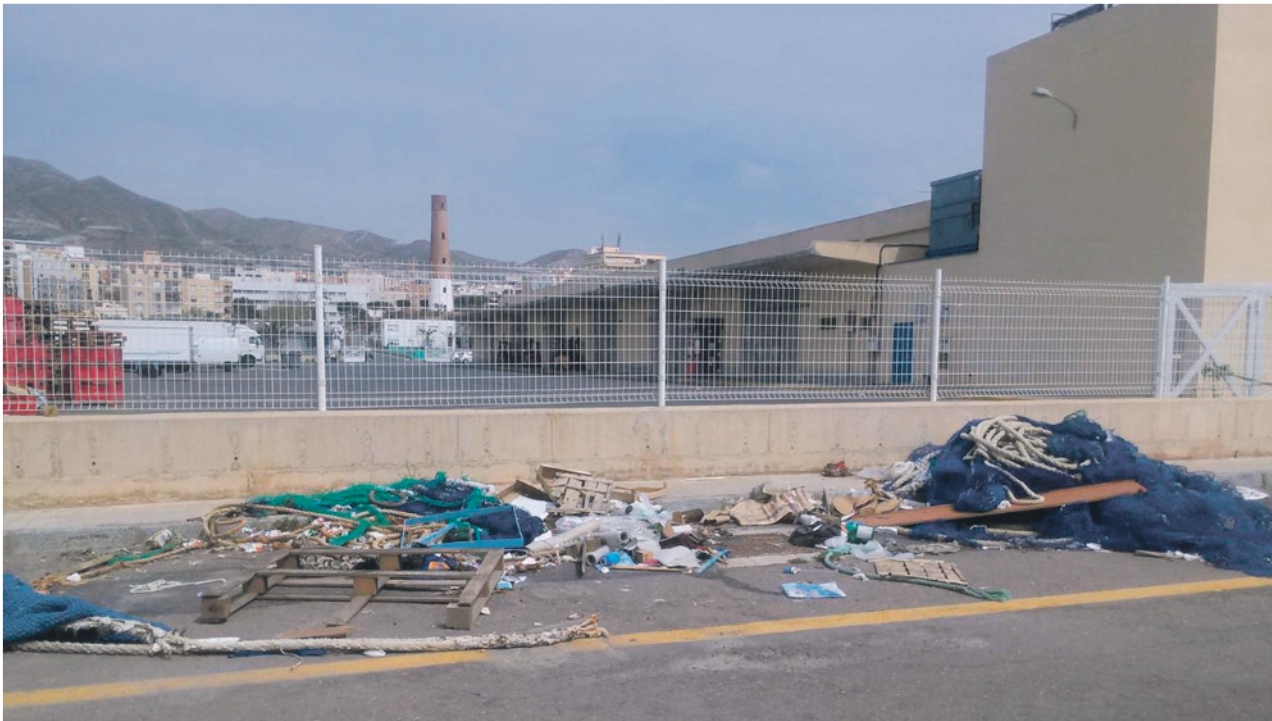
Estado actual de las instalaciones portuarias en Almería. / CNT AGRA
